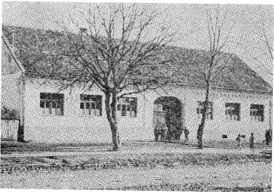
Gradište, renovirana stara škola, foto I. Kadić
