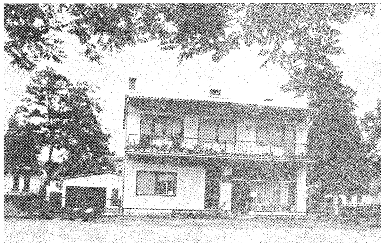
Nova ambulanta u Gradištu (1975)
